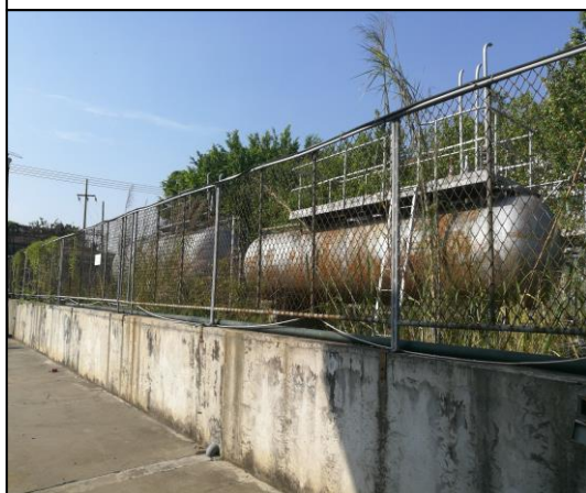
瓦斯罐（已空置）
